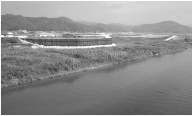
図 18 2004 年 10 月に決壊した円山川右岸堤防の復旧工事.
